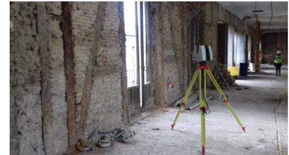
Identificación elementos muros panel
